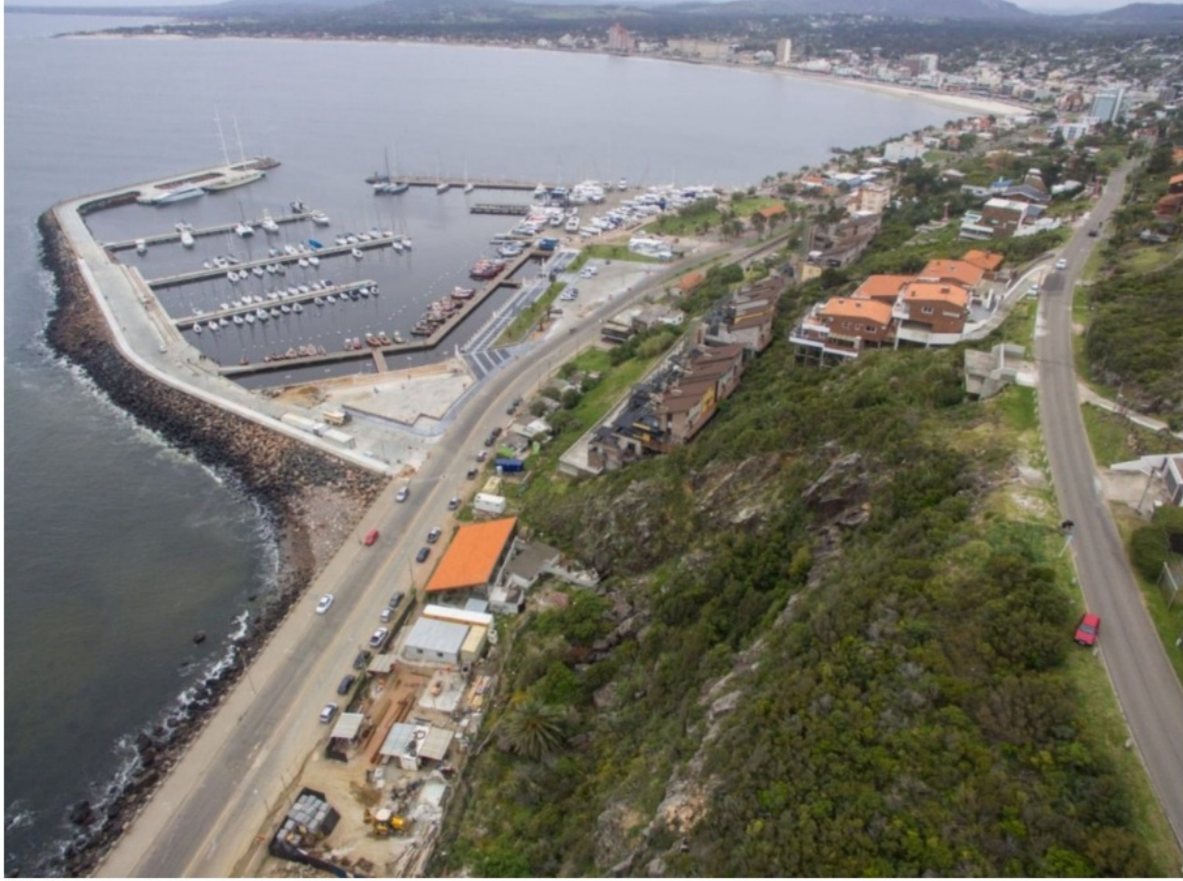
Vista desde el lugar donde se ubicará la plataforma
